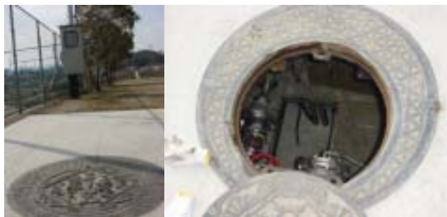
図1 エジェクタ式(EJ型)の設置例
