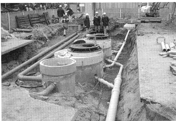
写真 1 真空ステーション施工中の様子
