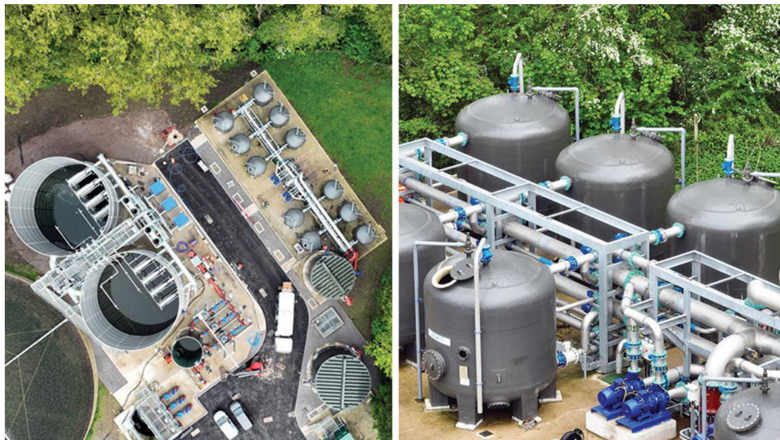
写真3 Yeovil Pen Mill下水リサイクル場 散水ろ床の隣に設置されたFilterClearシステム 出典：FilterClear, September 13, 2024 Water Projects Online
