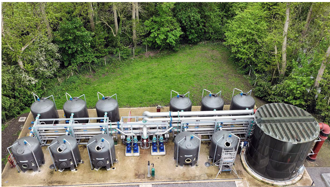
写真2 実稼働のFilterCleanモジュールユニット配置の様子
