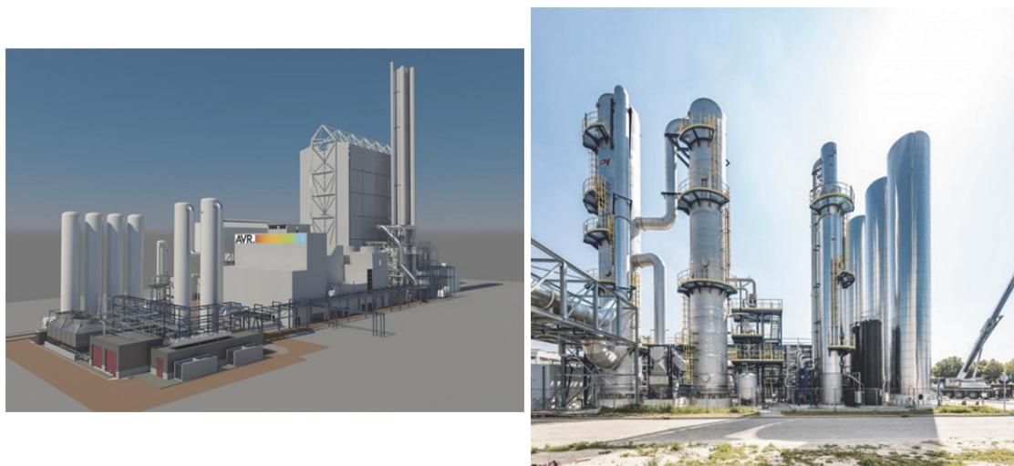
図2.4 AVR DuivenのCO 2 回収施設の外観
