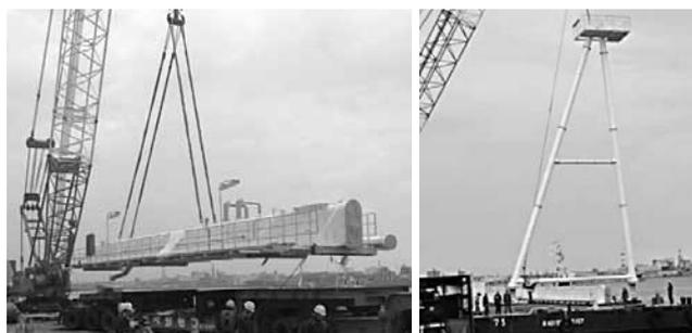
写真2 45m フレーム船積作業
