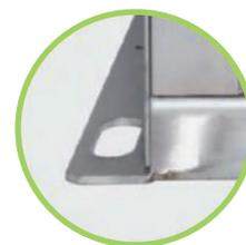
図3 ベースアンカ穴の長穴化
