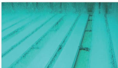
写真2 散気装置の発泡
