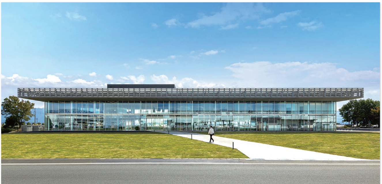
本社工場内に新設されたオフィス棟 COSMO TERRACE (コスモテラス) © 撮影: 株式会社Blue Hours (ブルーアワーズ)
