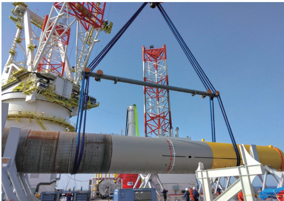
写真1 洋上風力発電機用モノパイル吊り(使用事例)
