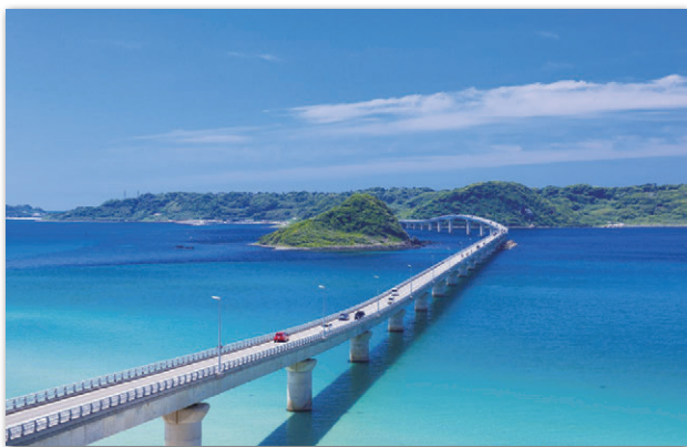
観光名所となっている角島大橋（当社一部施工）
