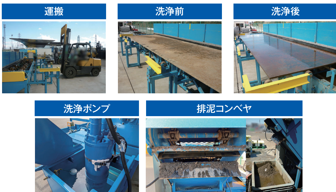
写真2 敷鉄板洗浄装置を用いた洗浄と排泥の様子
