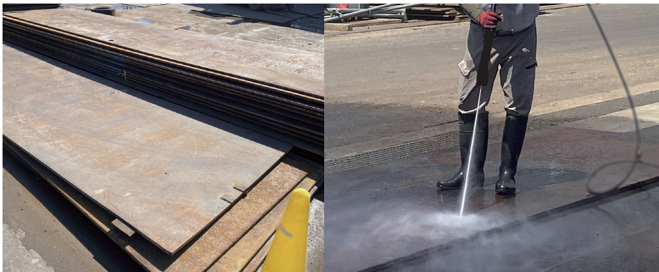
写真1 敷鉄板と人力による洗浄の様子
