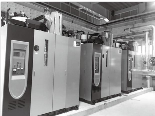
写真1 タイに納入した貫流蒸気ボイラ EQi-6001
