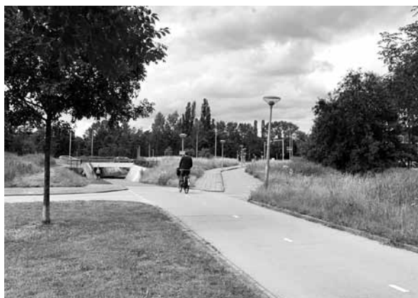
整備された自転車道と自転車用のトンネル(奥)
