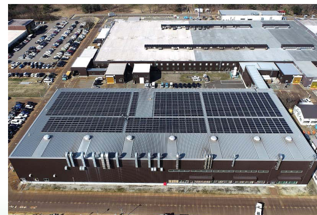
Pic.5 太陽光パネル
