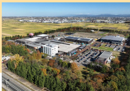
Pic.3 本社工場
