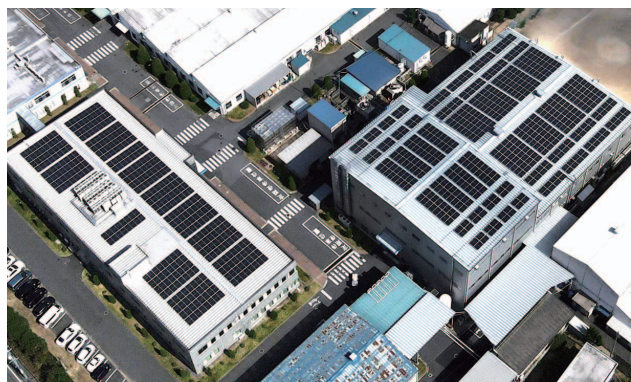
Pic.7 太陽光パネル
