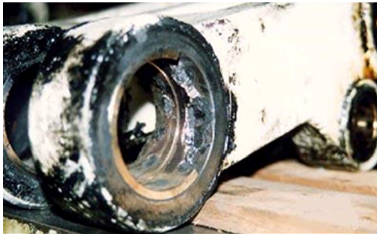
写真：摩耗が進行している(悪い例)
