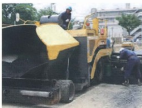
アスファルト舗装
