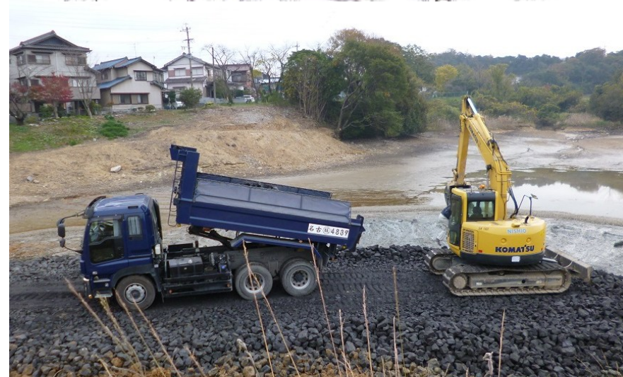
割石搬入・敷均し状況
