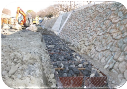
香流川：籠マット工詰め石（割ぐり石） サイズ：200～150mm
