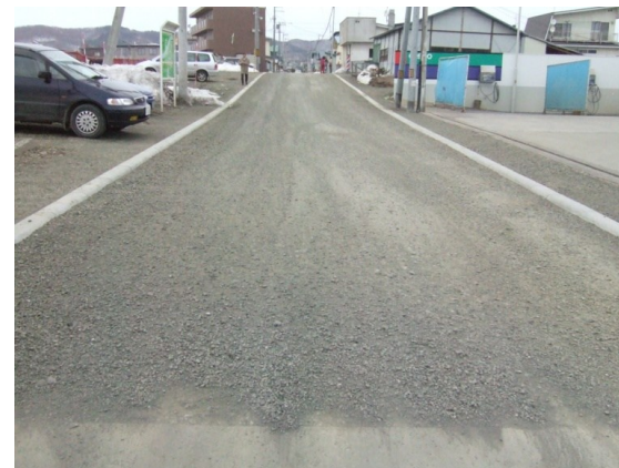
凍上抑制層実施工例(北見市 越冬後)
