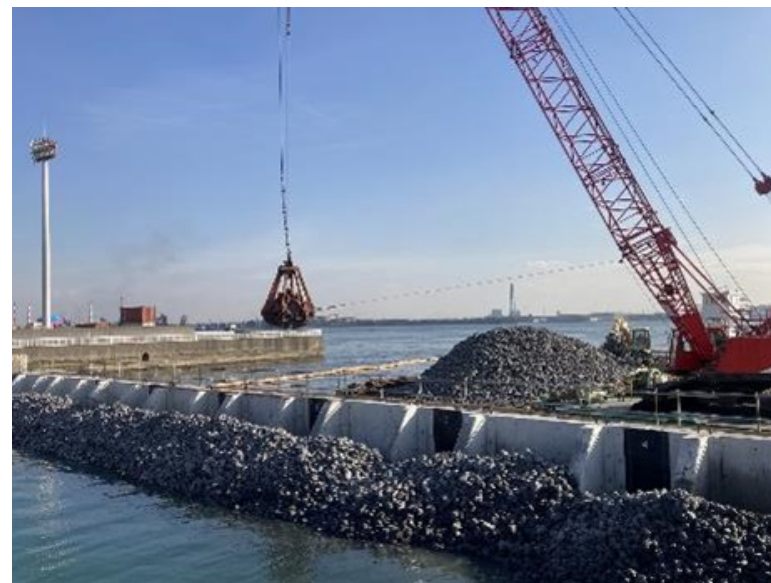
施工状況(裏込石の投入)
