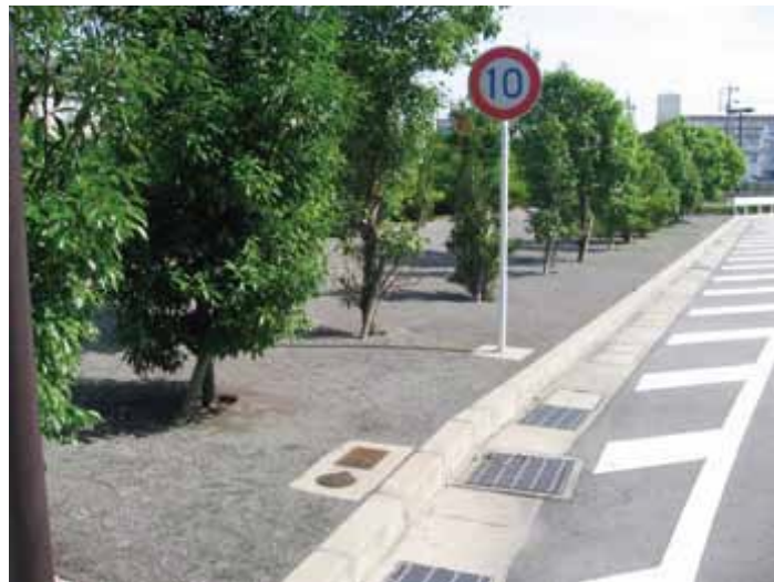
道路脇での施工例
