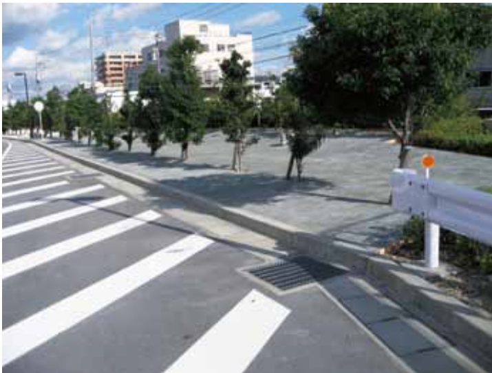
道路脇での施工例
