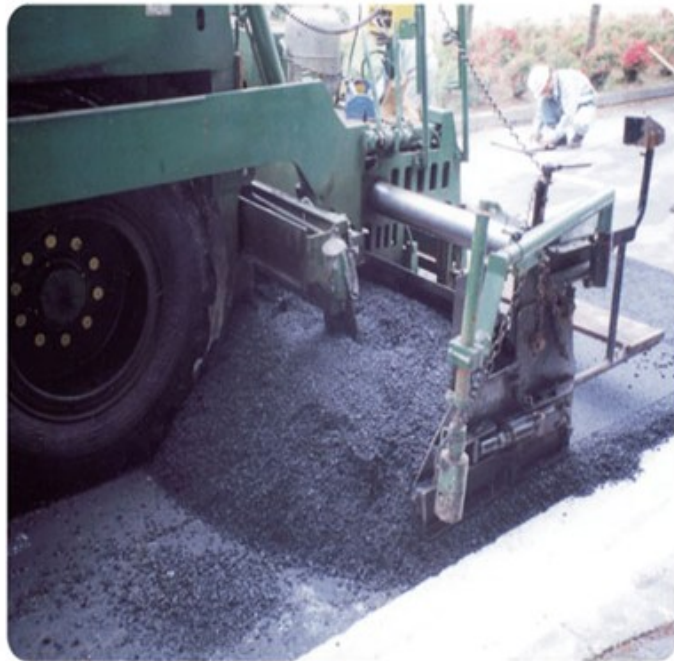
アスファルト舗装
