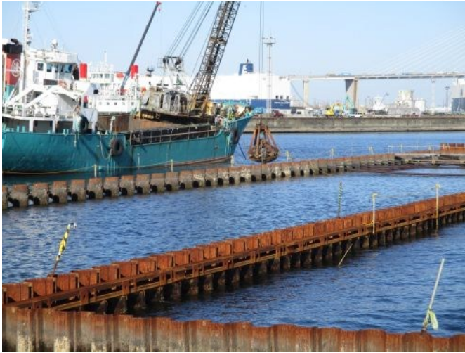
施工状況(裏込石の投入)
