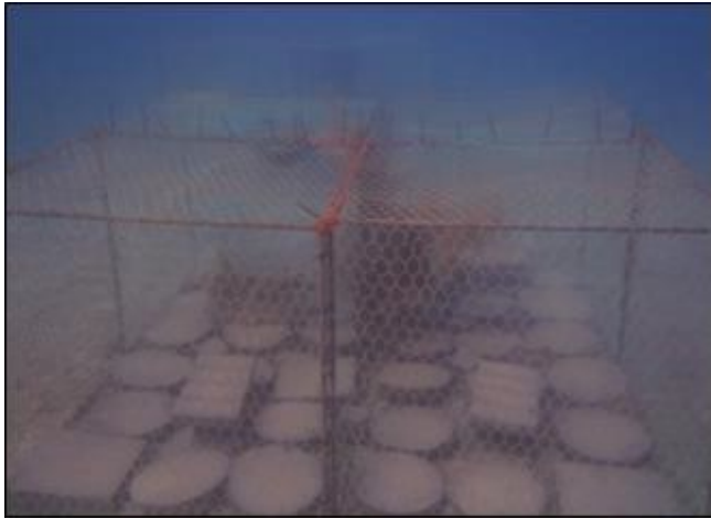
藻場ブロック設置直後の状況
