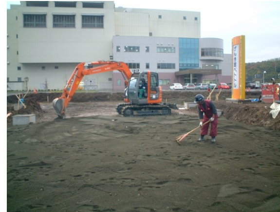
凍上抑制層の施工状況
