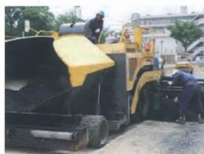
アスファルト舗装
