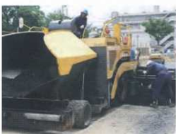
アスファルト舗装
