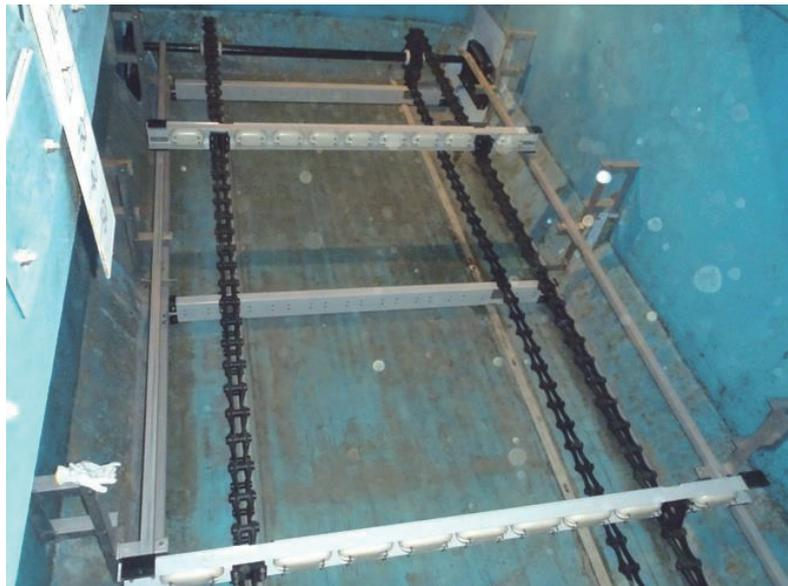
写真2 浮上型チェーンフライト式汚泥かき寄せ機実機2
