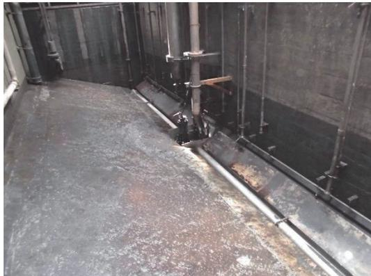
写真5 エジェクタ式集砂後状況
