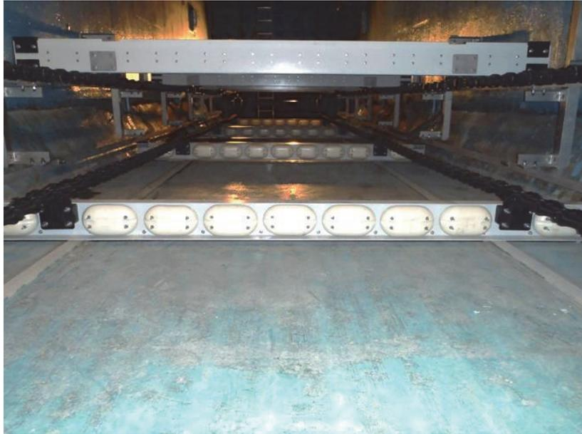
写真1 浮上型チェーンフライト式汚泥かき寄せ機実機1
