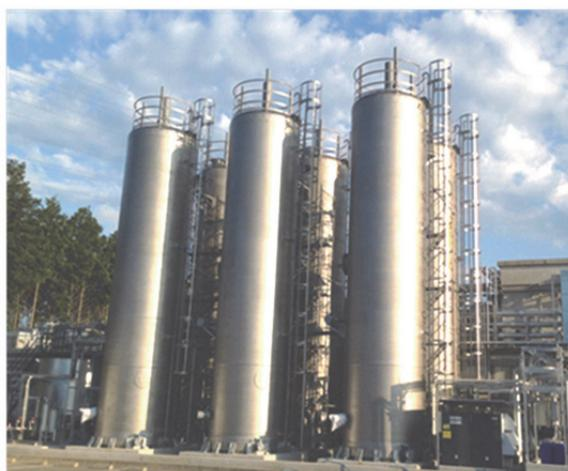
図 6 標準型排水処理装置の外観
