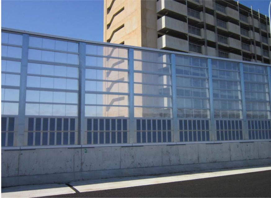
図 11 透光性吸音装置「エコキューオンクリア」
