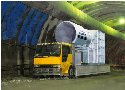
写真1 「トンネル工事用電気集じん器 e'-DUSCO（イーダスコ）」
