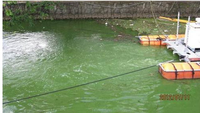
写真2 茨城県新川での実例（稼働後）
