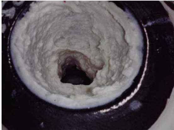
図 2-4 配管に付着増殖した糸状菌塊
