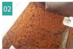
凝集混和タンク
