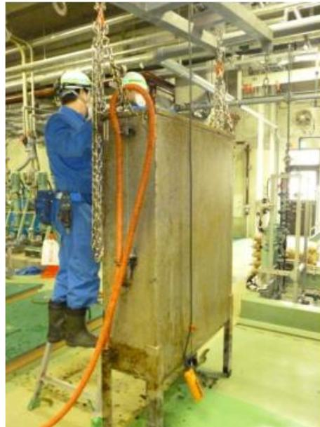
図表9 槽内型リアクタの引き揚げ作業（左）と点検作業（右）
