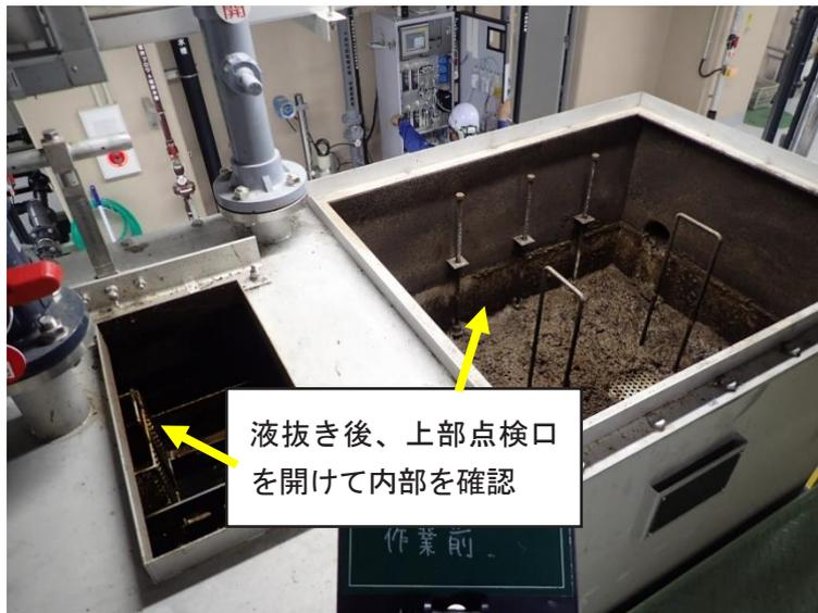
図表10 槽外型リアクタの点検作業
