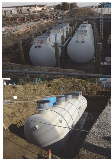
図4 大型浄化槽施工写真
