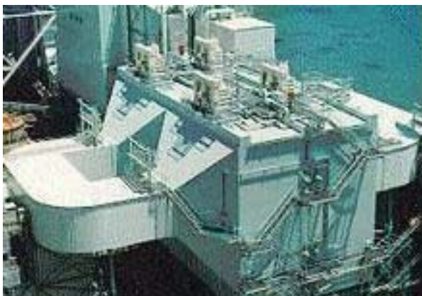
Pic.6 電気集塵装置
